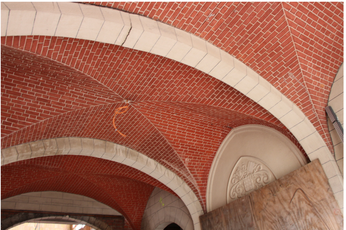
Bestaande dakgewelven in inkomhal worden behouden
