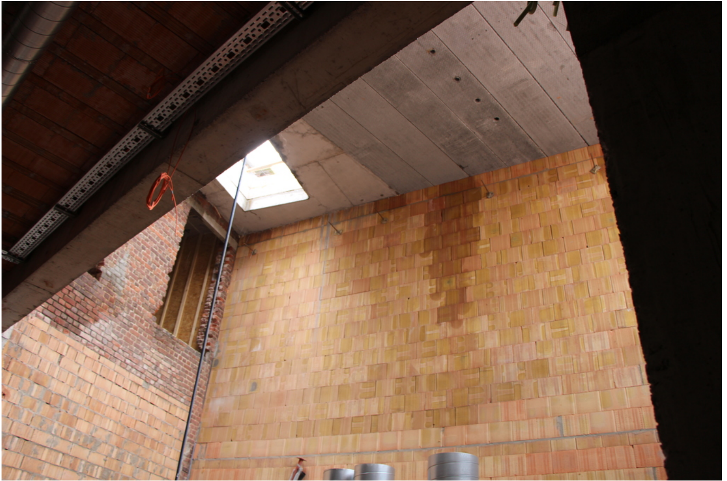
lichtstraat naar bovenste verdiepingen
