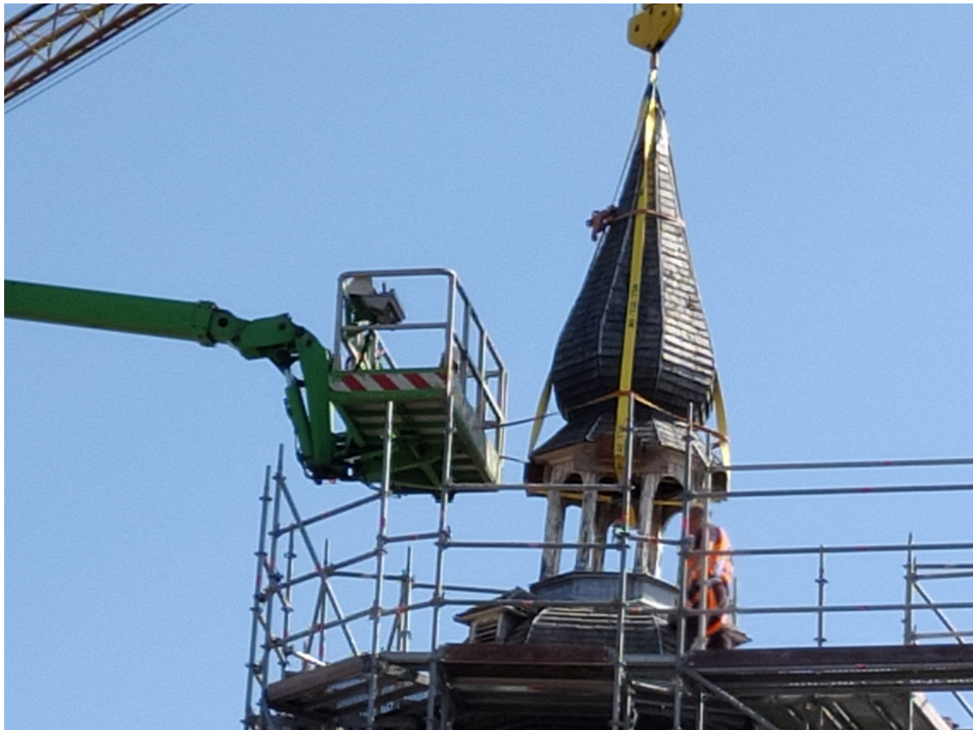
Ophangen bevestigingsmateriaal voor takelen
