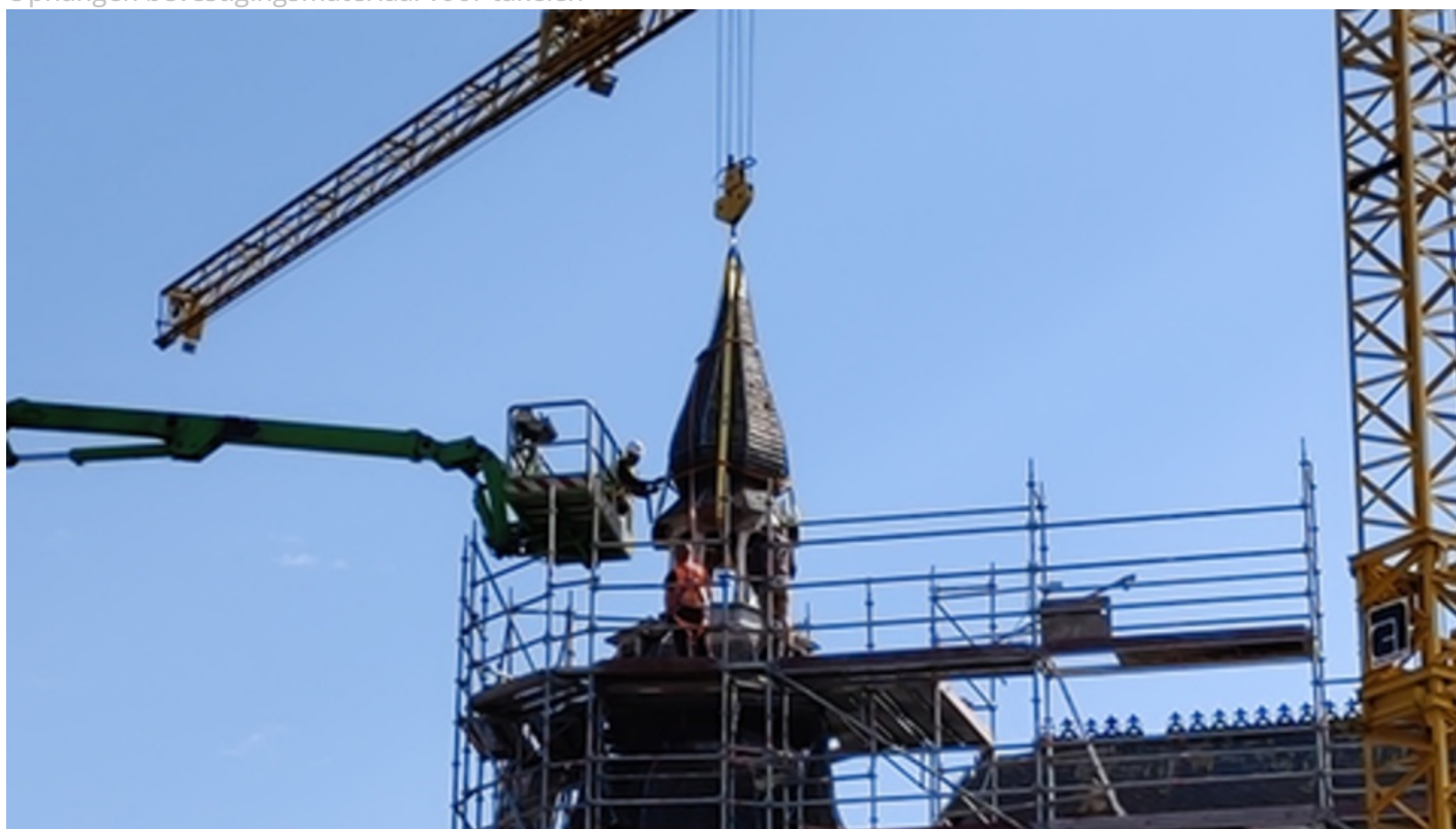
Ophangen bevestigingsmateriaal voor takelen
