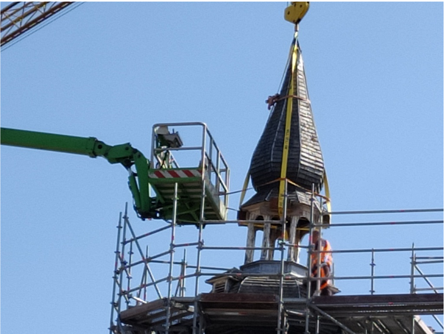
Ophangen bevestigingsmateriaal voor takelen
